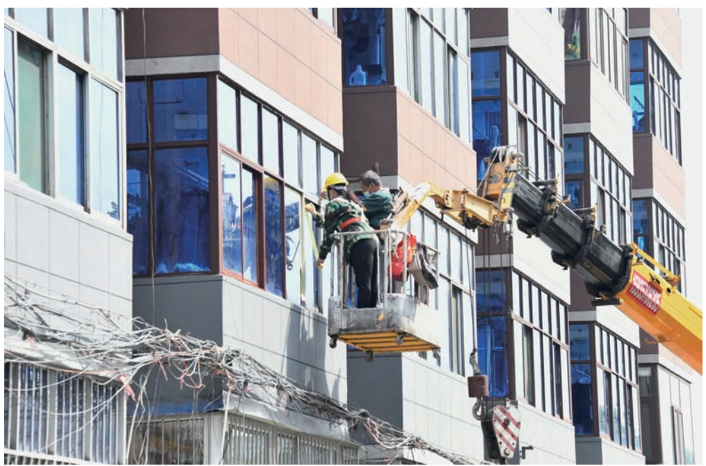
为了进一步改善城市面貌,提升城市品质,塑造城市形象,打造省域副中心城市,根据市、区《靓城提质“三大行动”实施意见》要求,我区对华州路楼体外立面及人行道实施提升改造工作,着力整治有碍观瞻的建筑物和环境卫生,使周边环境更加优美,群众幸福感和获得感得到提升,让“我为群众办实事”实践活动进一步走深走实。图为工人师傅正在沿街楼体外立面进行整治作业。 本报记者 刘凯杰 摄影报道
