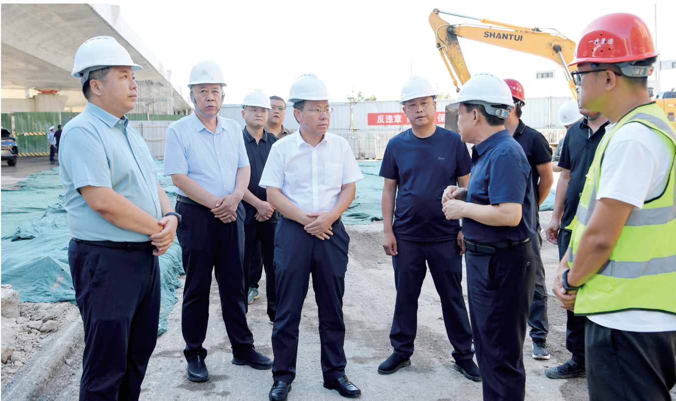
图为区委书记崔绍民等领导在华康路上跨尧贤街立交桥项目工地现场办公,协调解决项目推进过程中遇到困难和问题。
