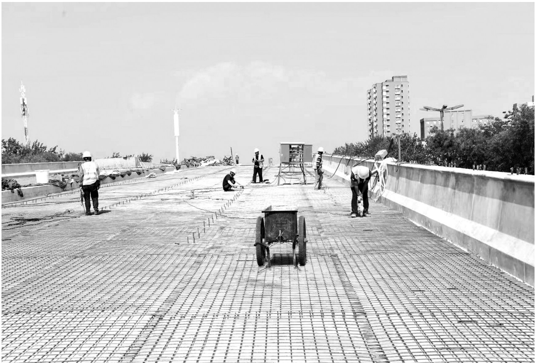
环城南路上跨尧贤街立交桥工程是“快速中环”南环道路的重要组成部分。该项目全长980米,主线上跨尧贤街,辅道与尧贤街平交,标准路段红线宽度60米,主线高架桥采用城市快速路标准,标准路段桥梁宽42.75米,为双向六车道,设计车速60千米/时。该项目预计9月底竣工通车。项目建成后,将有效缓解环内中心城区交通压力,完善城市综合交通体系。图为正在紧张施工的环境南路上跨尧贤街立交桥工程。
